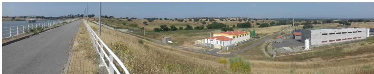
Figura 5. Barragem e Estações Elevatórias da Amoreira (Panorâmica).
