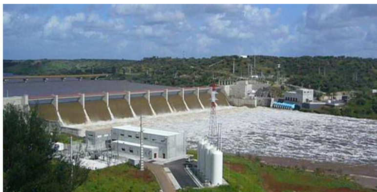
Figura 2. Barragem de Pedrógão.
