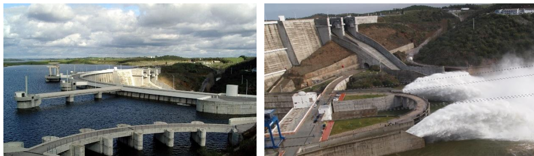
Figura 1. Barragem de Alqueva - vistas de Montante e Jusante.
